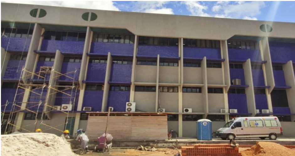
Figura 19 – Reforma do prédio do Hemocentro Coordenador - Belém
